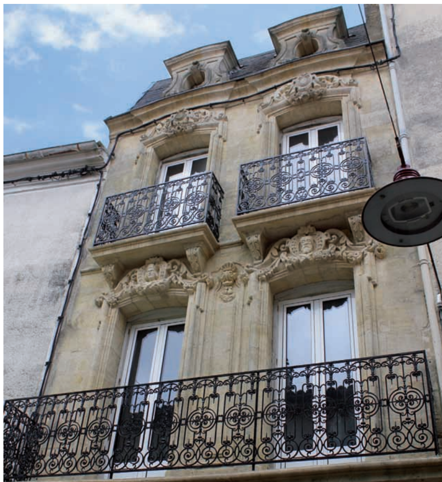
Des appartements dans un immeuble rénové rue Maubec.
