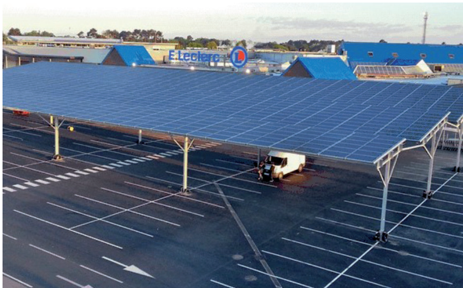
1600 m 2 de panneaux photovoltaïques pour fournir 15% des besoins en électricité du Leclerc.
